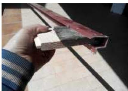
Ritirate da noi oppure da un lattoniere di vostra fiducia una scossalina con sagomatura come in figura , da poter inserire ai bordi della struttura. Nel lato inferiore si può anche inserire una gronda per la raccolta delle acque.
